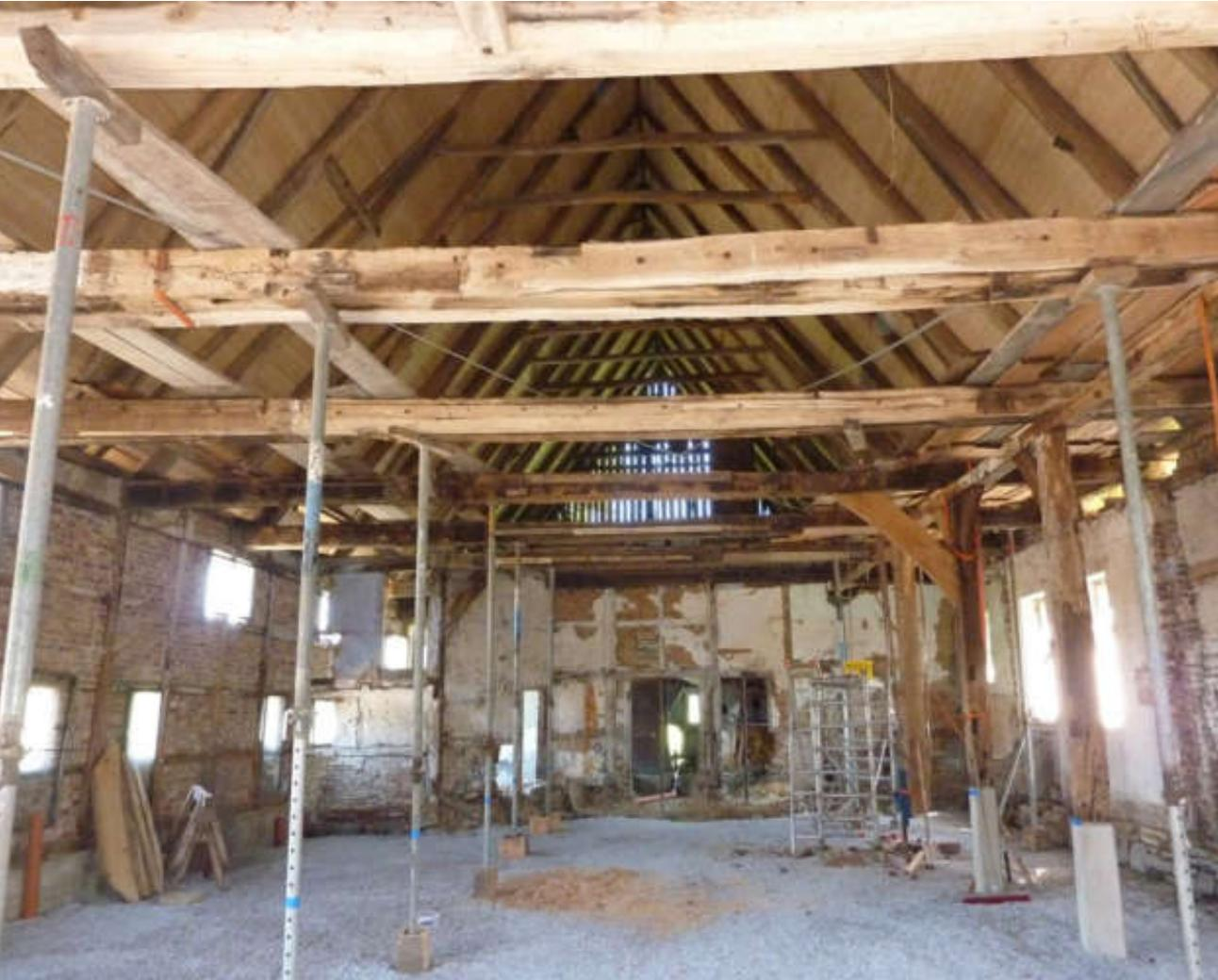
*Die Diele im Wiederaufbau. Die rechte teilweise renovierte Ständerreihe wurde auf die ursprüngliche Position von 1517 wieder nach außen versetzt. Die linke Reihe ist zur Reparatur ausgebaut.*
