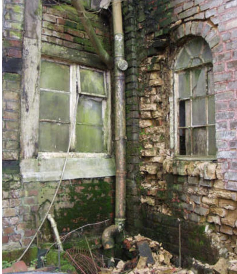
*Eindringendes Wasser hatte über die ganze Länge des Pottstalls schwere Schäden verursacht und das Wurzelwerk armdicker Birken und Weiden seinen Teil an der Zerstörung beigesteuert. Um das Haupthaus retten zu können, musste der Stallanbau rechts abgerissen werden.*
