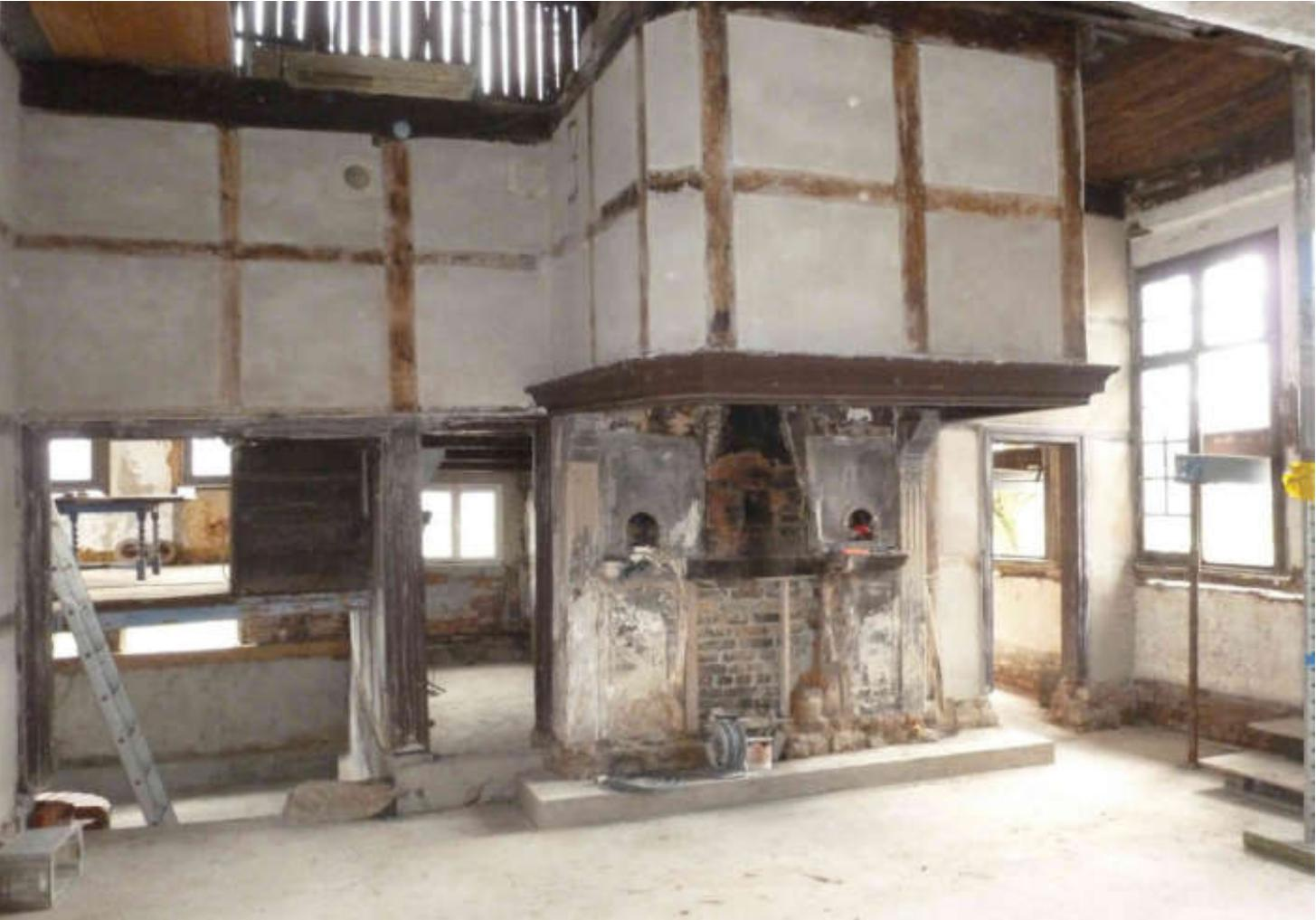
*Der vermutlich 1789 eingebaute Kamin mit dem verkleinerten Rauchabzug von 1860 während der Sanierungsarbeiten.*
