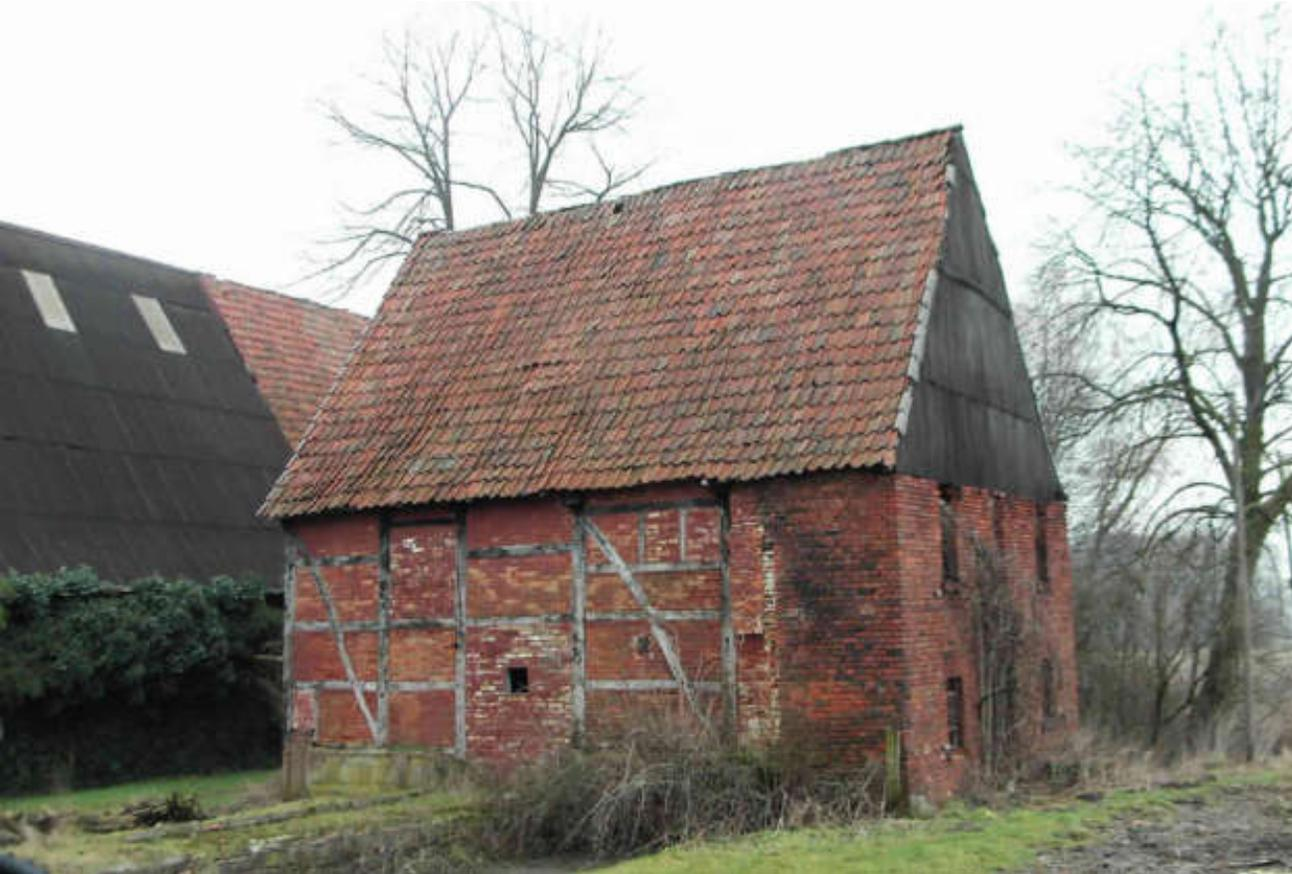
*Auch der Speicher von 1823 wies fundamentale Schäden auf. Der Südgiebel musste vollständig entfernt werden, weil das vorgesetzte Mauerwerk keine statische Verbindung mehr zum Fachwerkteil hatte. Auf den Speicher zulaufend sind die Fundamentreste des zum Viehstall umgebauten ehemaligen Göpelhauses zu sehen.*
