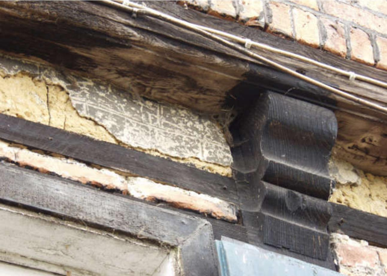
*Eine der Knaggen, die die Vorkragungen des Giebels abstützen. Der abgeplatzte Putz links wurde im späten 18. Jahrhundert auf den Lehmputz gezogen und dann bemalt, um eine Vermauerung mit Steinen vorzutäuschen. Gut zu erkennen sind die Linien der Fugenimitation.*
