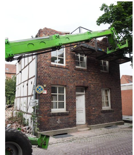
Abriss Altstadtthaus in Lüdinghausen
