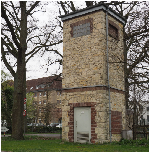
Historischer Transformatorenturm in Dülmen-Karhaus
