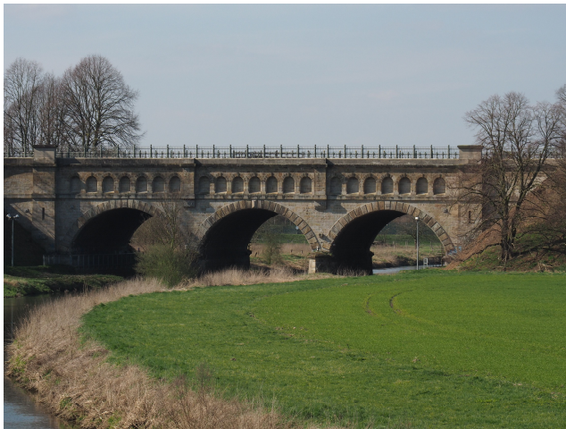
Kanalbrücke „Alte Fahrt“ über die Lippe in Olfen
