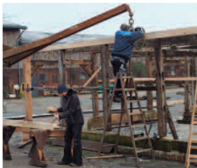
Zimmerleute beim Wiederaufbau
